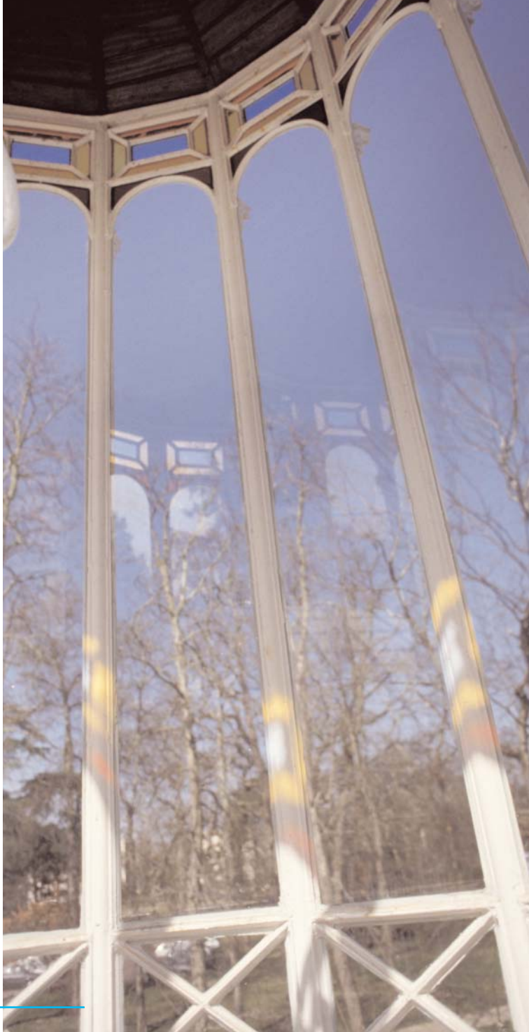
La serre et ses merveilleuses découpures de métal permises par de nouvelles techniques de travail du fer
