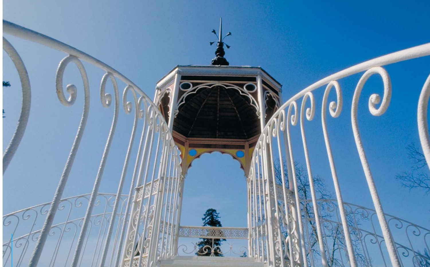
Passerelle accédant au clocheton surmontant la serre
